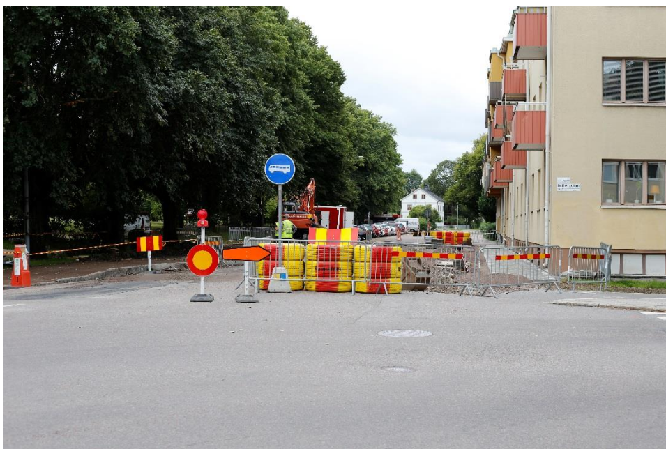
Exempel på omledning av trafik vid schaktarbete.
