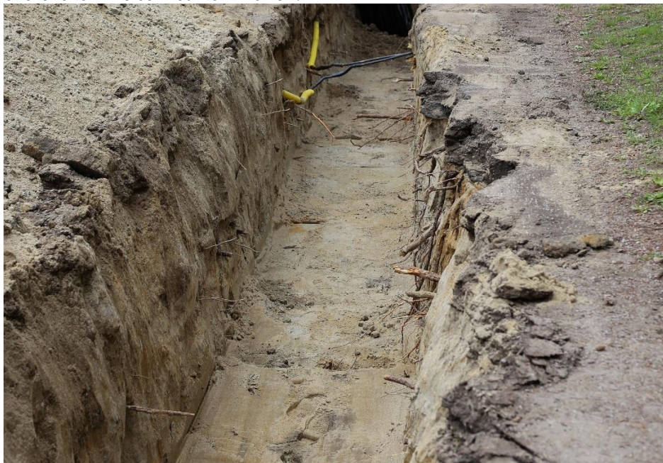
Korrekt beskurna rötter i kabelgrav.
