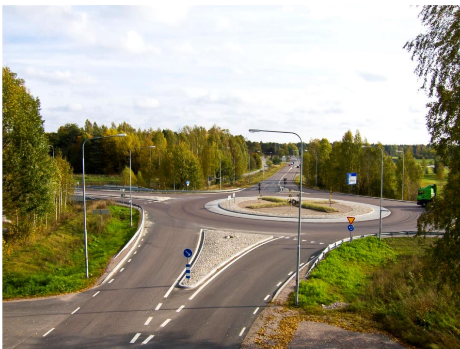
Alla grävningar medför en försämring av gatan. Därför är det viktigt med samordning som gör att antalet grävningar i gatorna kan begränsas.
